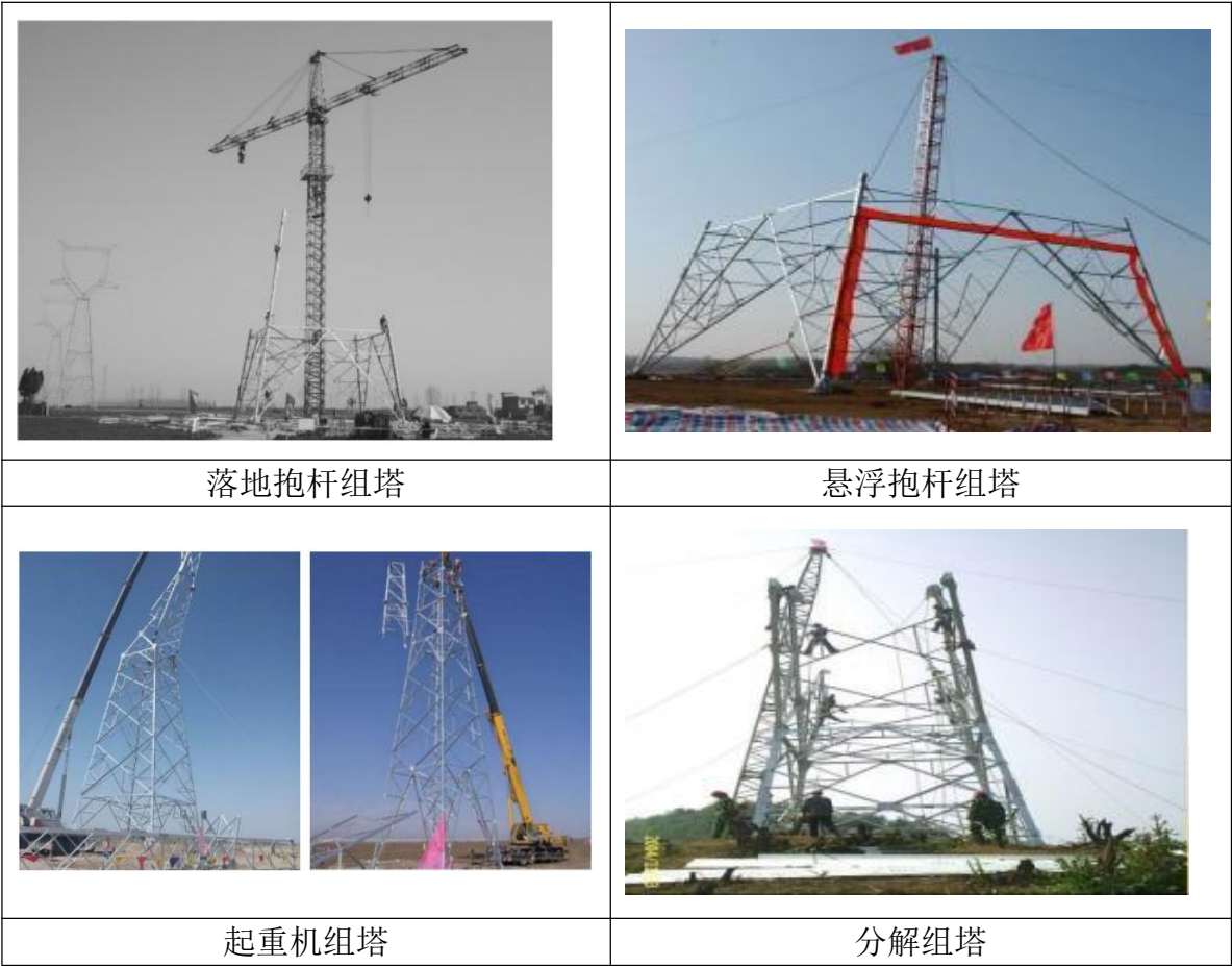
图 3.1-5 线路工程铁塔组立现场影像示例
