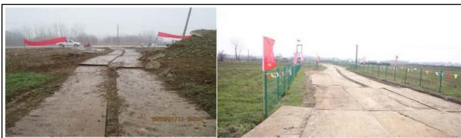
图7.1-4 临时道路铺设钢板实例示意
