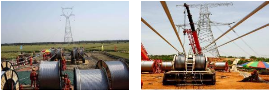
图 3.1-2 线路工程牵张场布置及张放线影像示例
