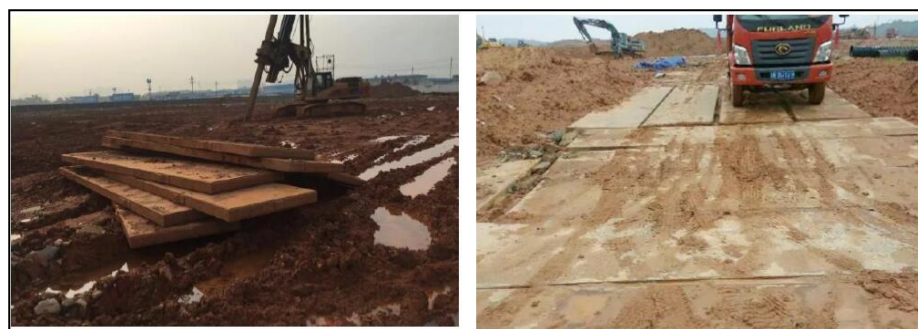
图7.1-5 临时道路路基箱铺设实例示意
