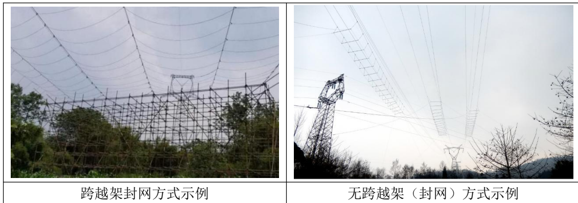
图 3.1-3 线路工程临时跨越方式施工影像示例
