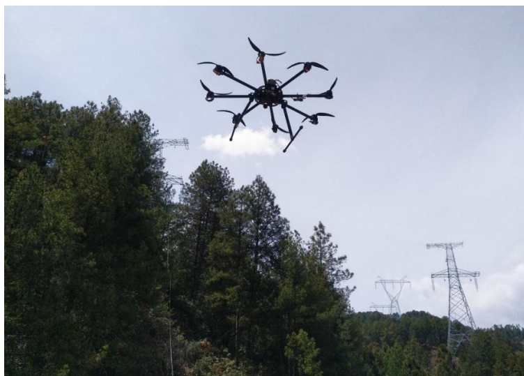
图 3.1-6 无人机放线施工示例
