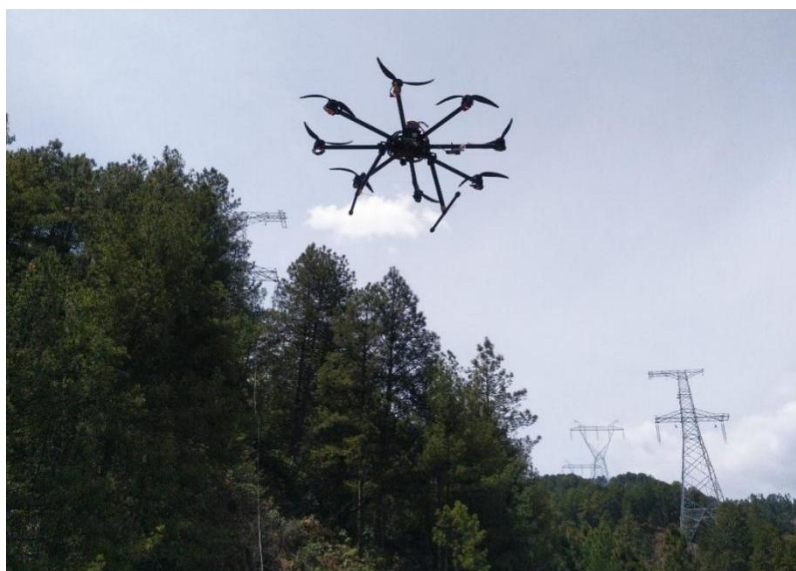
图 2-6 无人机放线施工示例
