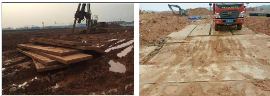
图5-3 临时道路路基箱铺设实例示意
