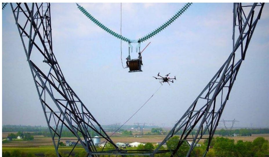
图 5-5 无人展放初级牵引绳示例
