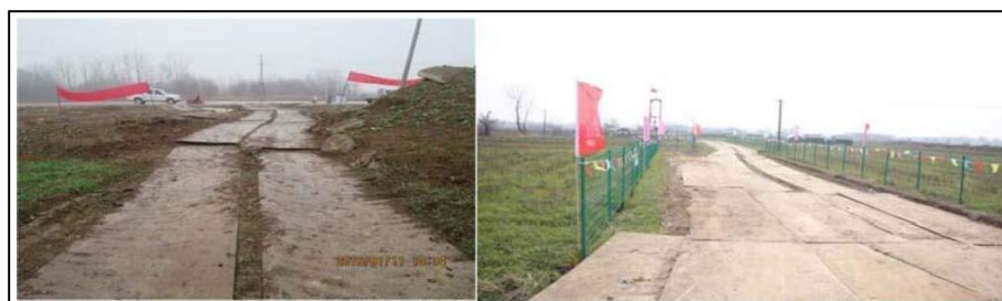
图5-2 临时道路铺设钢板实例示意
