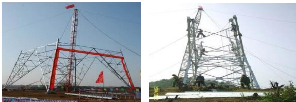
图 2-5 线路工程铁塔组立现场影像示例
