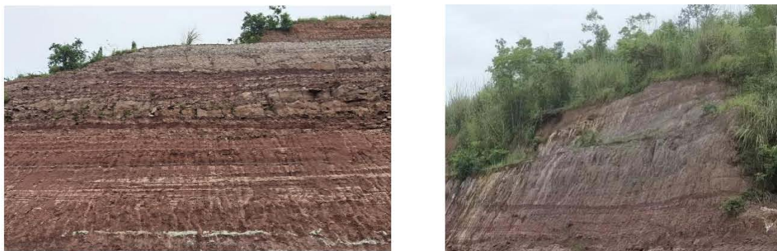
图 3.1.5-5 调查区局部裂隙发育照片
