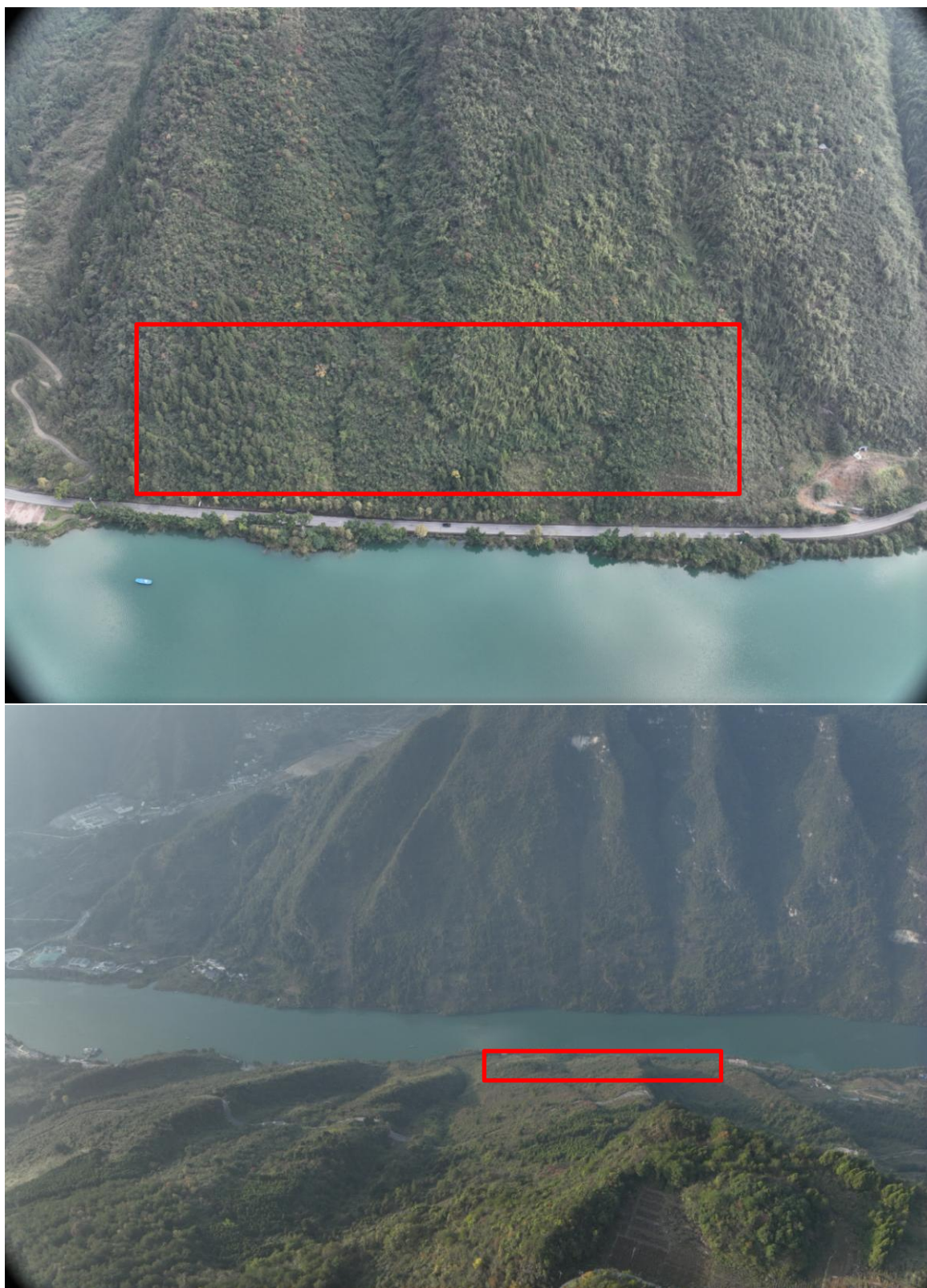
图 3.5.2-1 地面开关站区域航拍图
