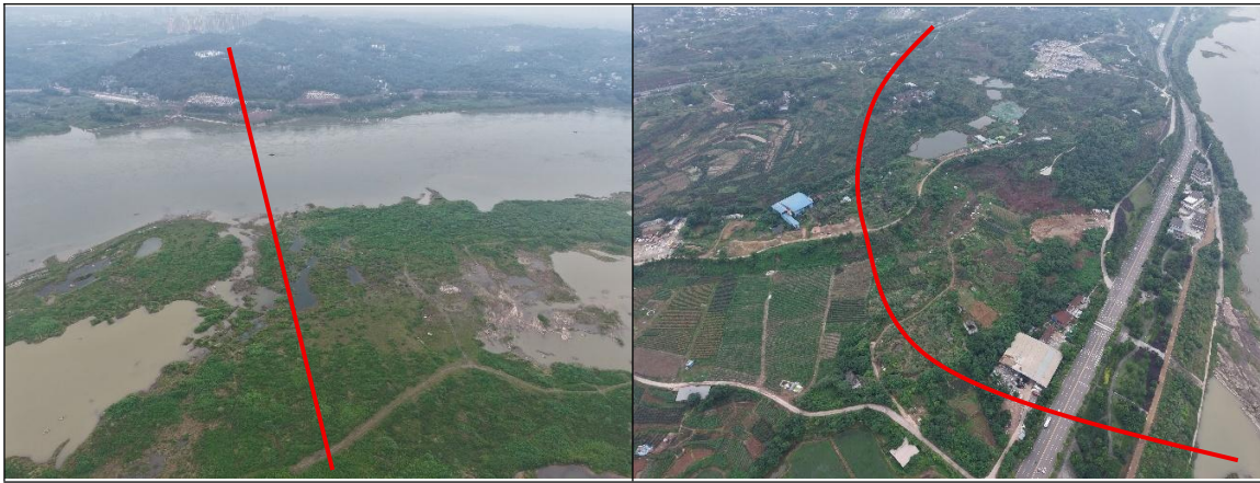
图 3.1-1 道路沿线现状航拍照片
