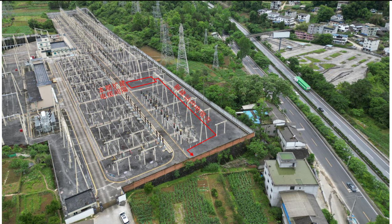
图 2-2 彭水 220kV 变电站间隔扩建工程现状照片
