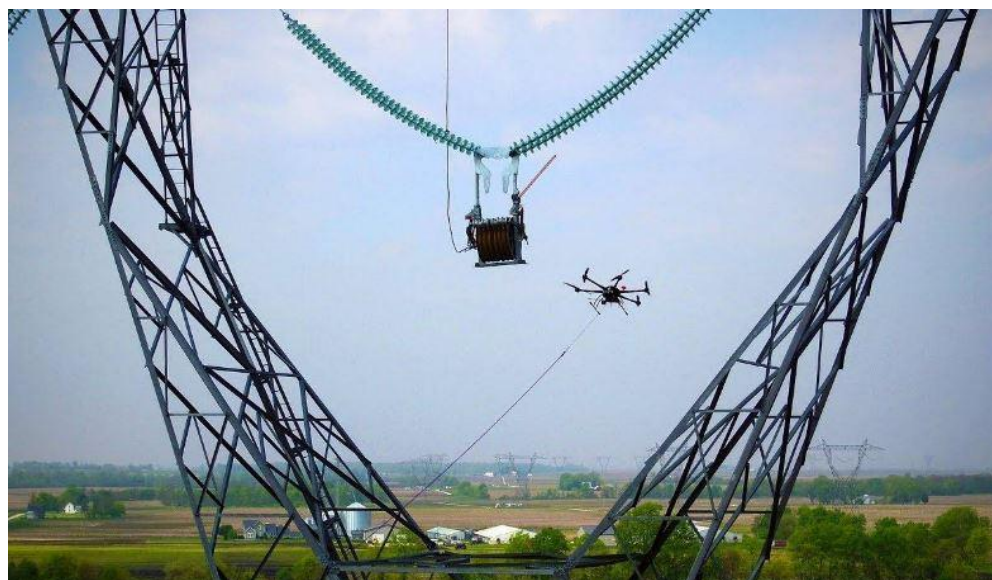
图 5-5 无人展放初级牵引绳示例
