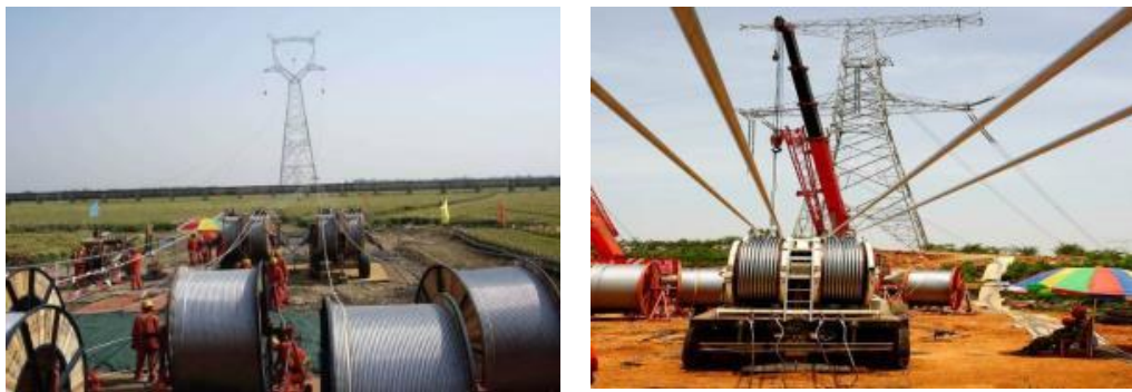
图 2-6 线路工程牵张场布置及张力放线影像示例
