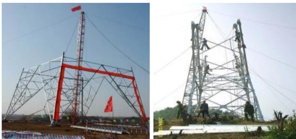
图 2-4 线路工程铁塔分解组塔现场影像示例
