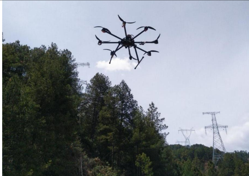
图 2-5 无人机放线施工示例
