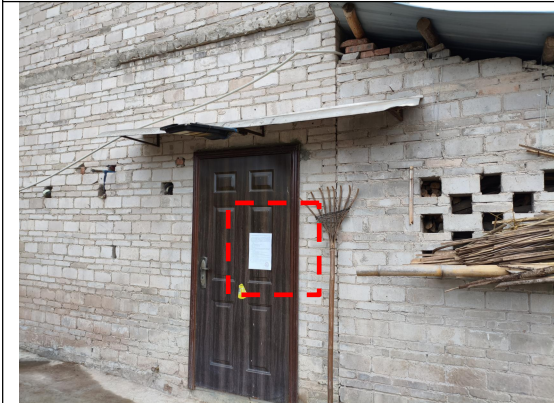
新店村最近民房处（线路部分）
