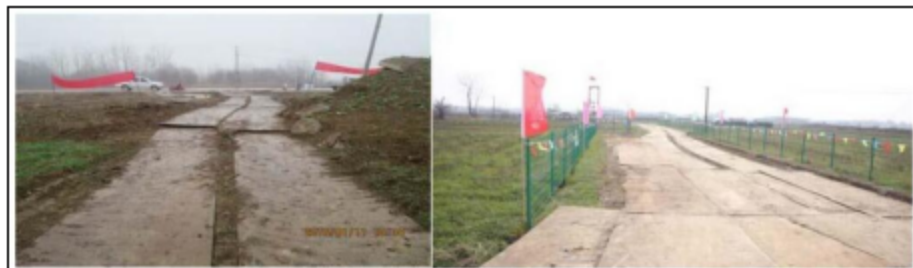
图7.6-3 临时道路铺设钢板实例示意
