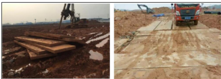
图7.6-3 临时道路铺设钢板实例示意
