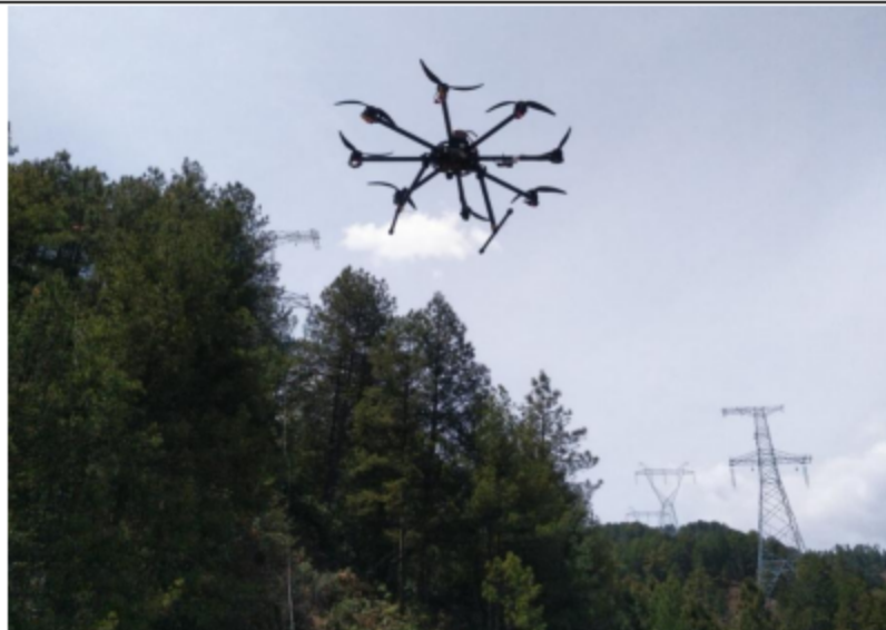
图 3.1-6 无人机放线施工示例
