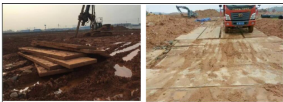
图7.6-4 临时道路路基箱铺设实例示意
