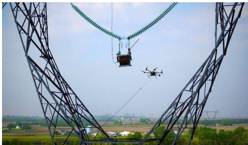
图 5-5 无人展放初级牵引绳示例
