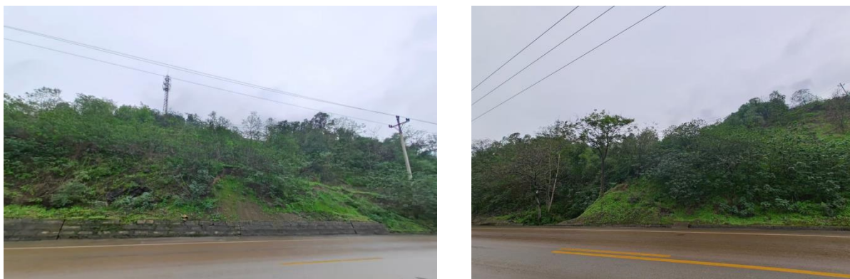
图1.5.5-1 项目东侧现场踏勘图
