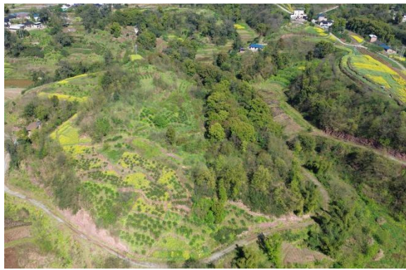
220kV 送出线路沿线植被
