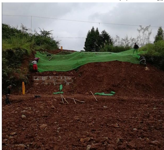
施工作业带彩条布覆盖过程
