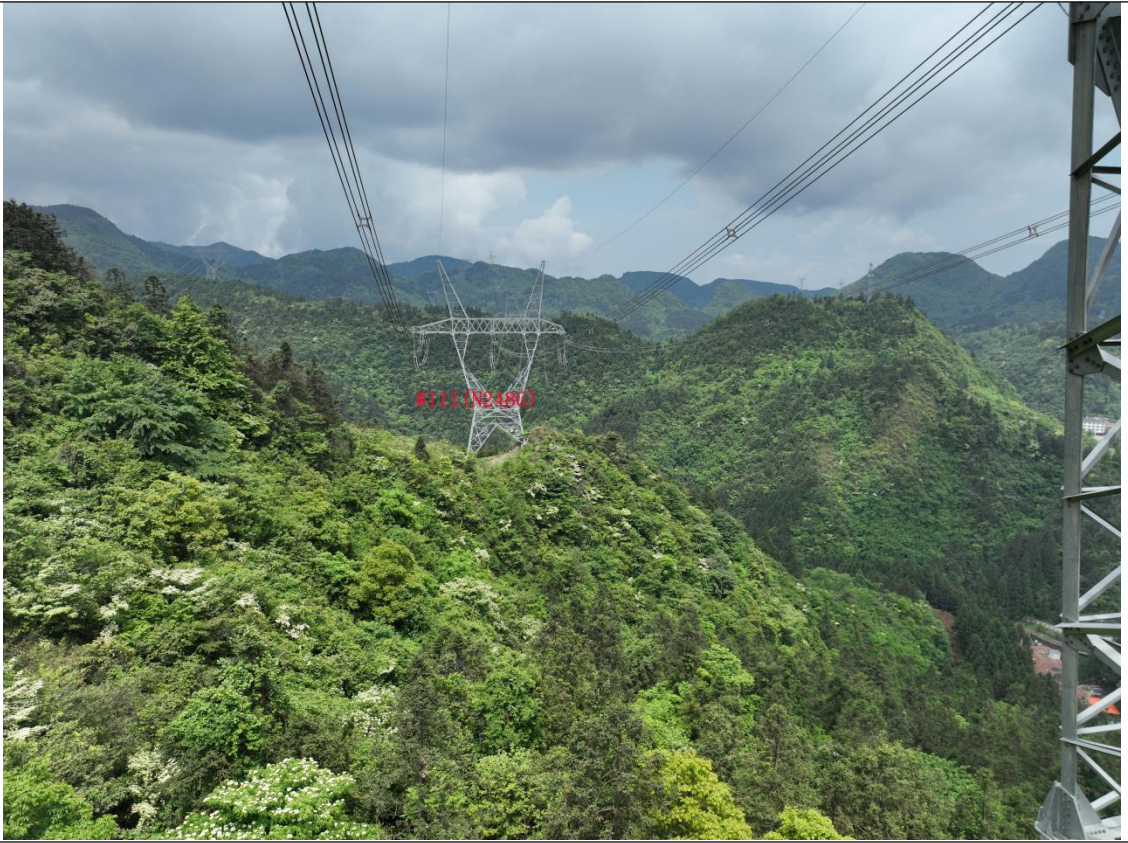
500kV 张隆一线 生态恢复情况 2025 年 9 月
