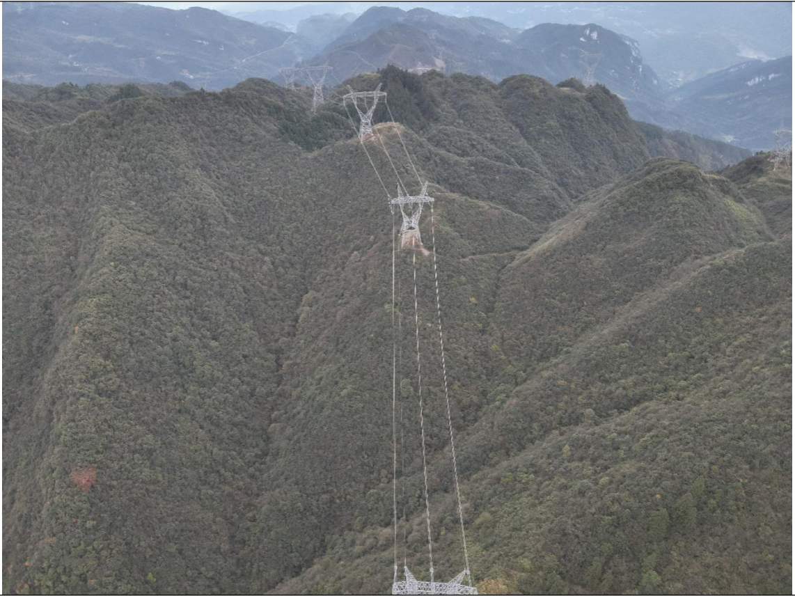
500kV 张隆一线 生态恢复情况 2026 年 2 月
