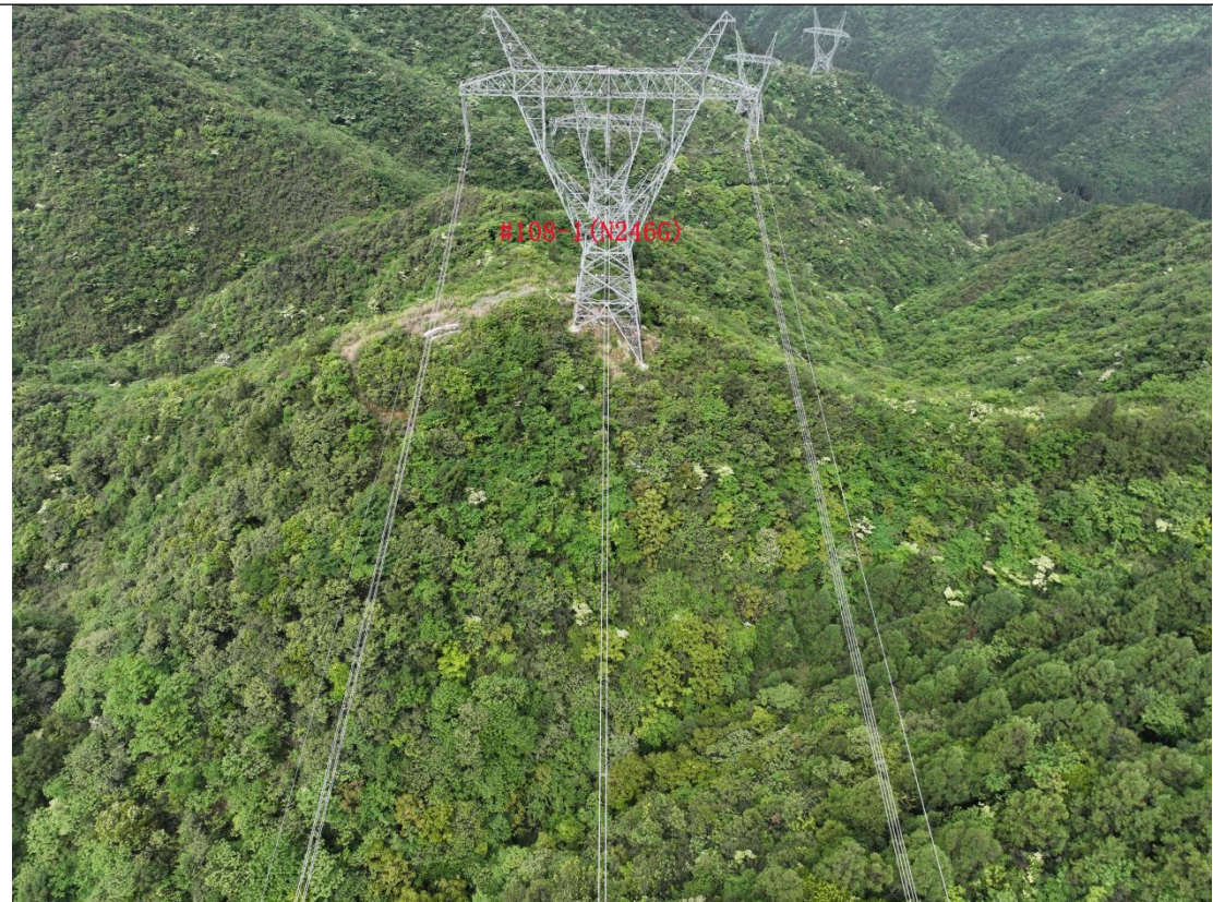
500kV 张隆一线 生态恢复情况 2025 年 9 月
