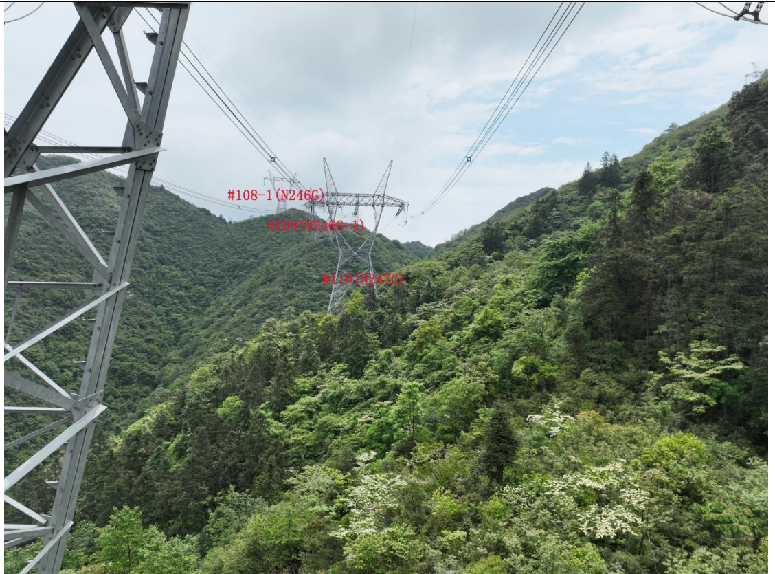
500kV 张隆一线 生态恢复情况 2025 年 9 月
