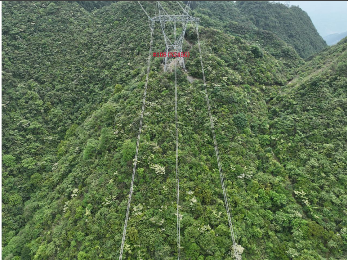
500kV 张隆一线 生态恢复情况 2025 年 9 月
