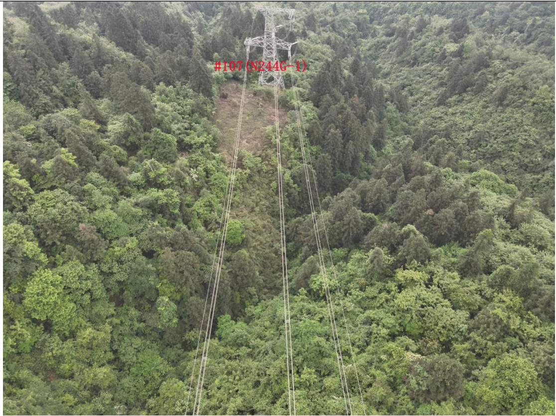
500kV 张隆一线 生态恢复情况 2025 年 9 月
