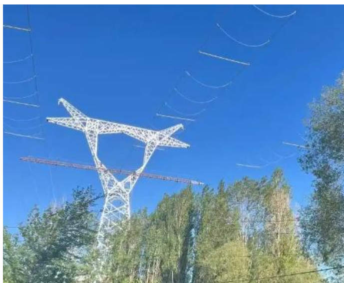
图 2-2 输电线路横担封网搭设影像实例
