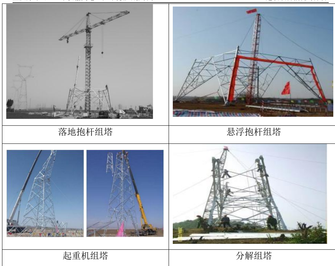
图 3.1.7-5 线路工程铁塔组立现场影像示例
