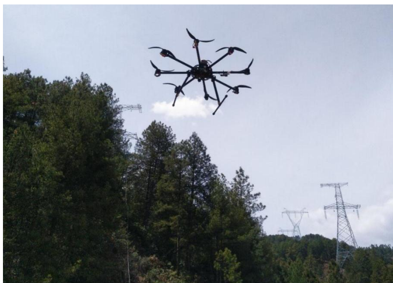
图 3.1.7-6 无人机放线施工示例
