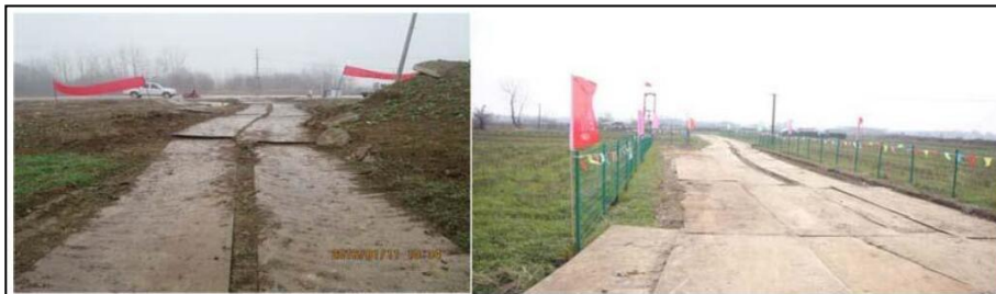
图7.1.1-3 临时道路铺设钢板实例示意
