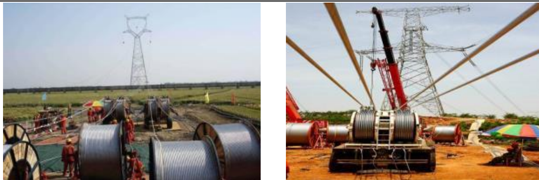
图 3.1.7-2 线路工程牵张场布置及张放线影像示例
