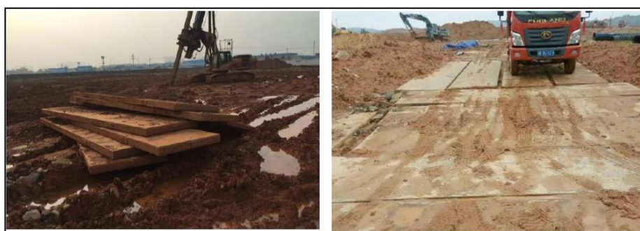
图7.1.1-4 临时道路路基箱铺设实例示意
