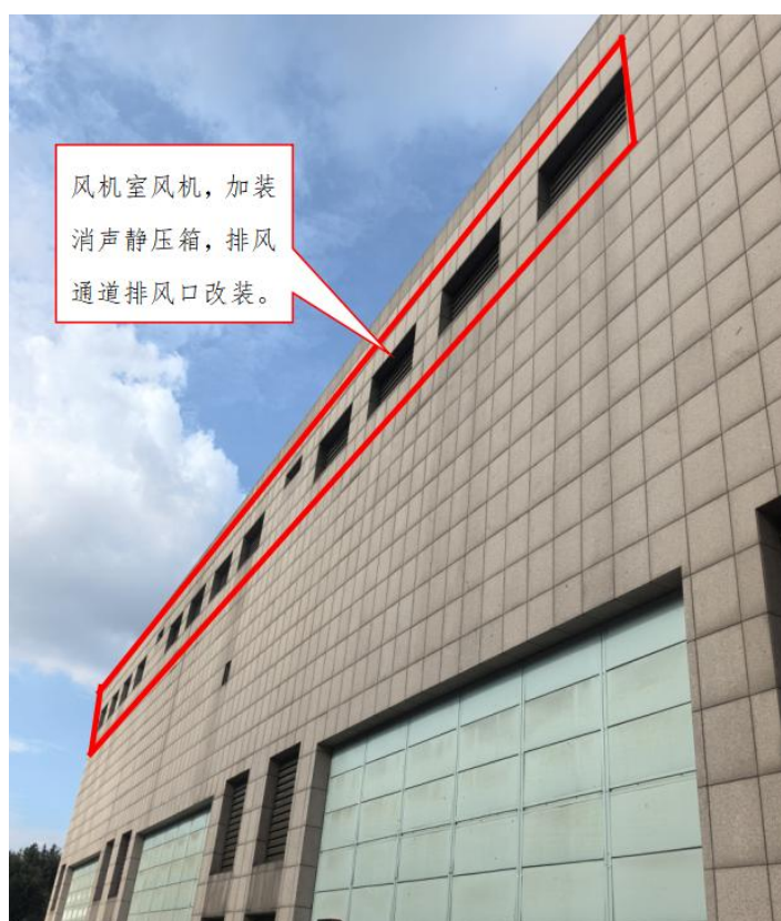
图 4.8-1 排风口改装示意图
