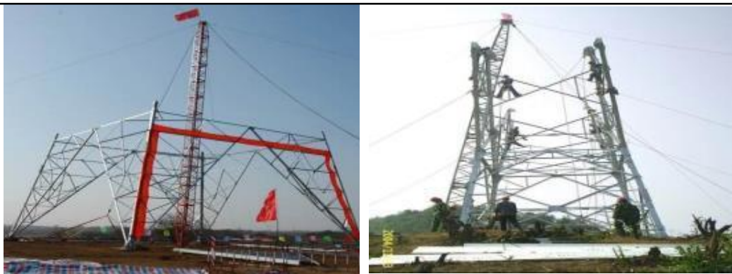
图 2-6 线路工程铁塔组立现场影像示例
