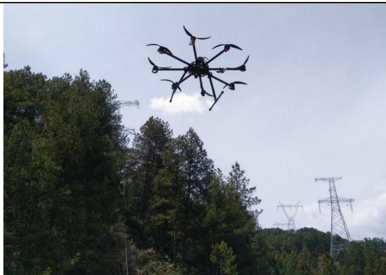
图 2-7 无人机放线施工示例
