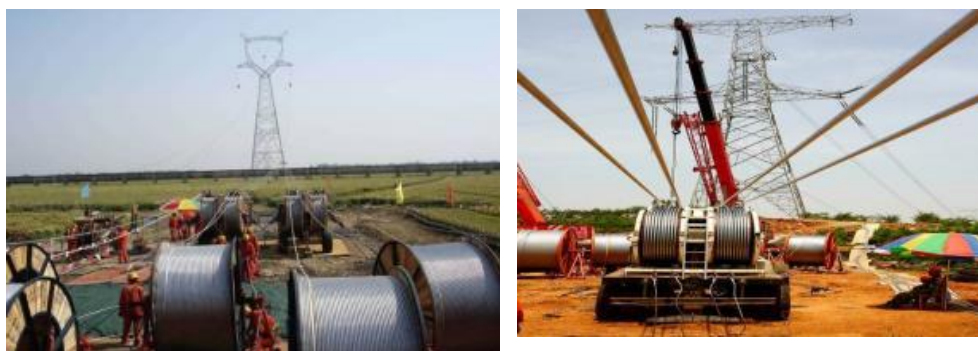
图 2-2 线路工程牵张场布置及张放线影像示例
