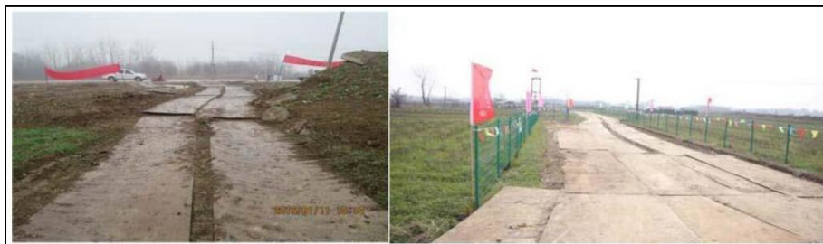
图5-2 临时道路铺设钢板实例示意
