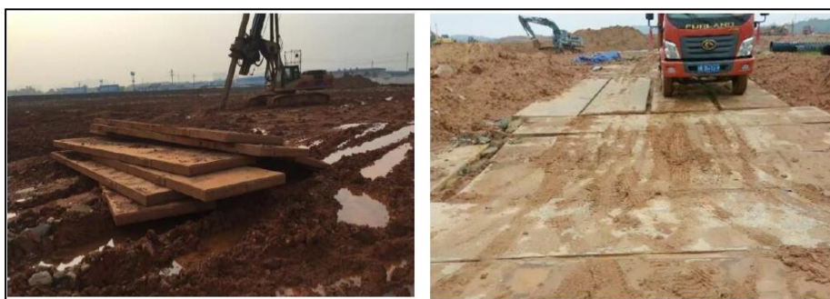
图5-3 临时道路路基箱铺设实例示意
