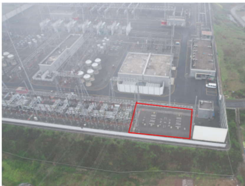
图 2.3-1 铜梁 500kV 变电站间隔扩建示意图
