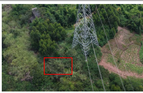
拆除塔基恢复现状
