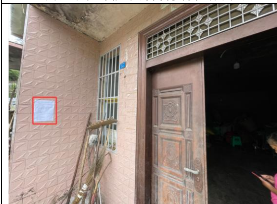
南川区楠竹山镇隆兴村民房处
