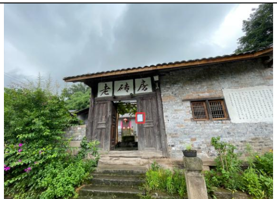
南川区西城街道永合社区民房处
