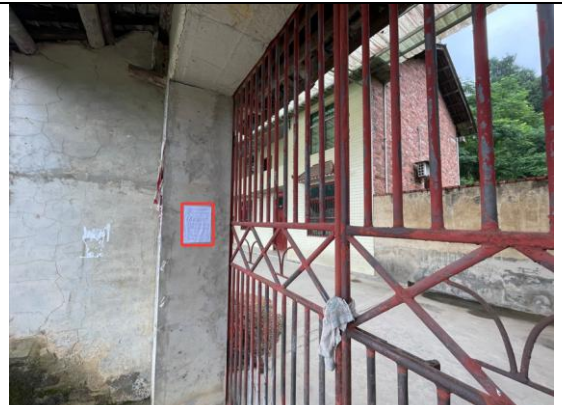
南川区楠竹山镇隆兴村民房处
