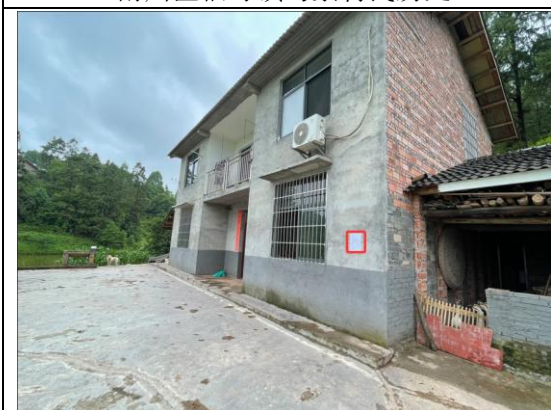
南川区河图镇长坪村民房处
