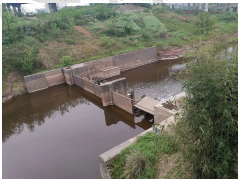
图 7.7-1 大陆溪河入长江前事故应急坝
