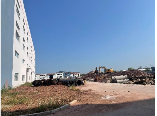
CT 室东侧车间外道路
