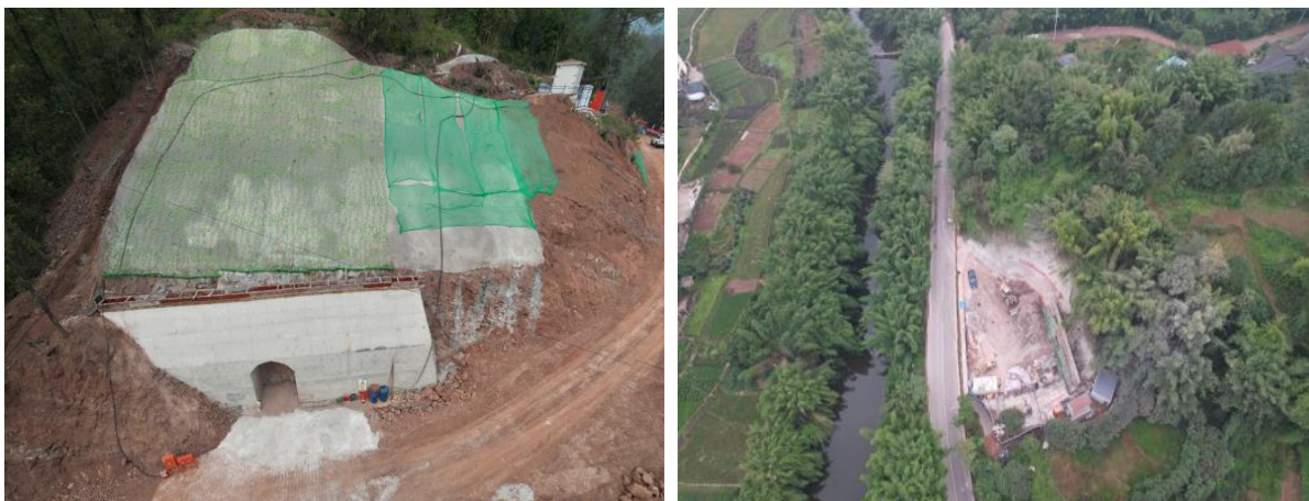
图 2.4-4 正在施工的右干渠黄荆岗隧洞进出口
