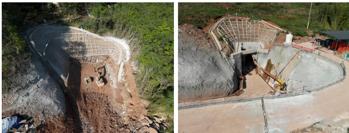
图 2.4-2 正在施工的总干渠花土岗隧洞进口和大河沟箱涵
