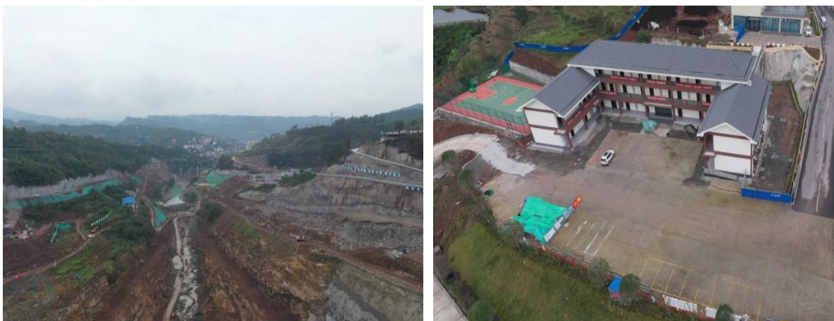
图 2.4-1 在建的藻渡水库大坝和业主营地
