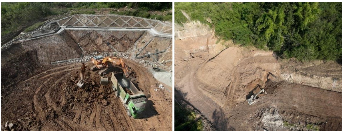
图 2.4-2 正在施工的总干渠花土岗隧洞进口和大河沟箱涵
