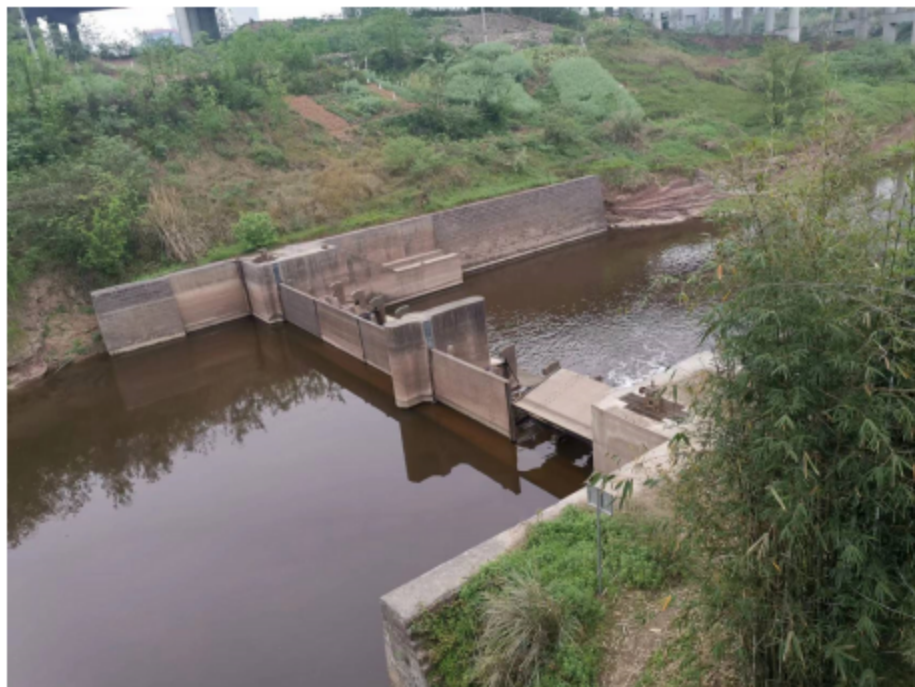
图 7.9.2-1 大陆溪河入长江前断面事故应急坝
