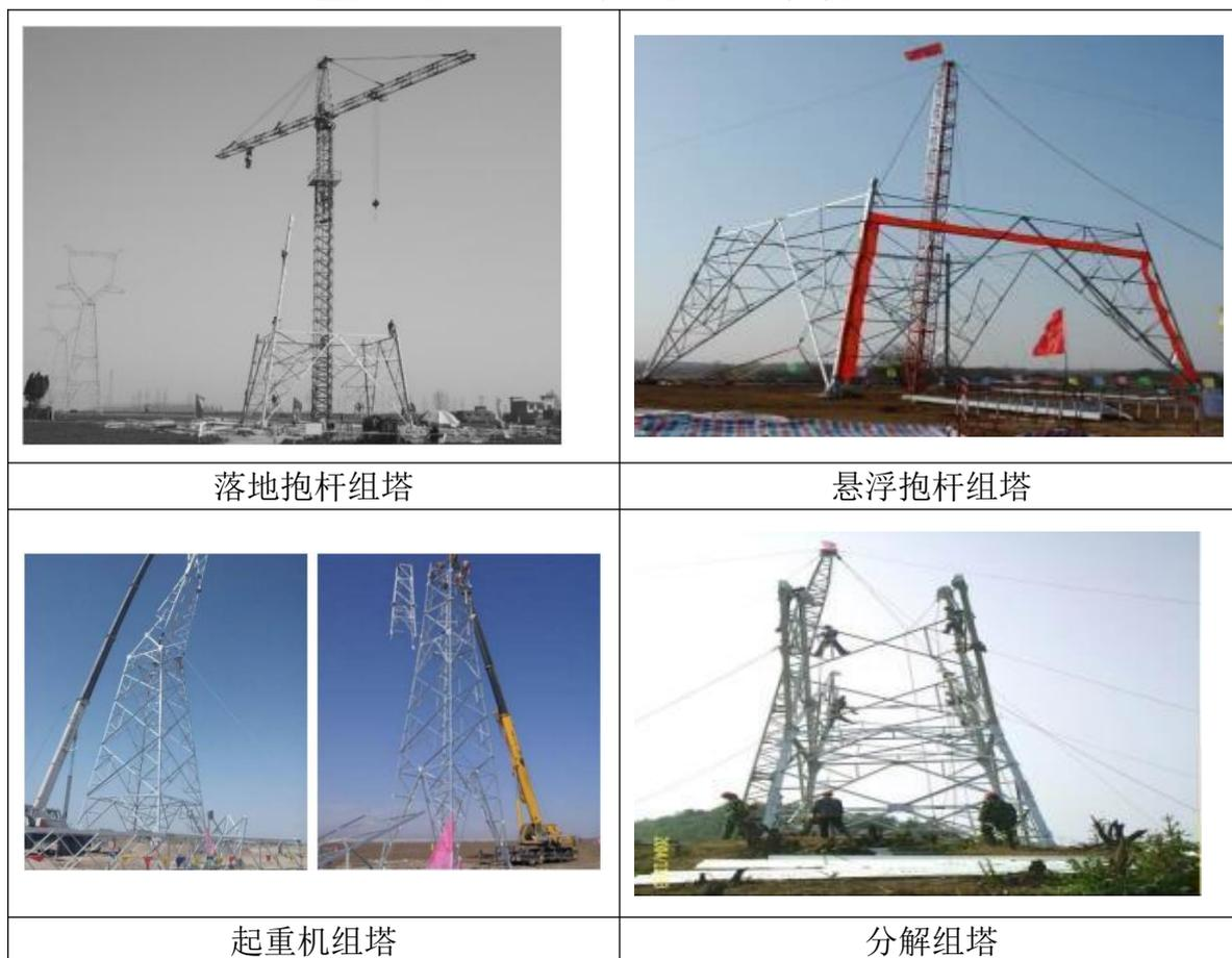
图 3.1-7 线路工程铁塔组立现场影像示例
