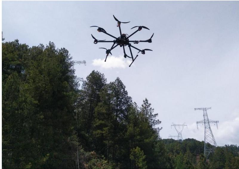
图 3.1-8 无人机放线施工示例
