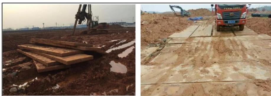
图7.6-5 临时道路路基箱铺设实例示意
