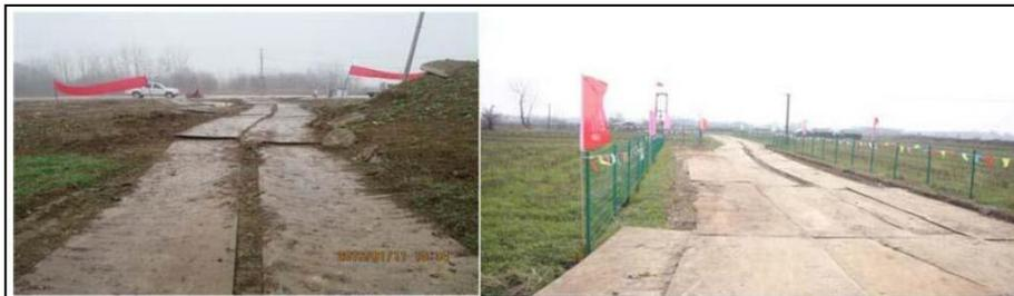
图7.6-4 临时道路铺设钢板实例示意
