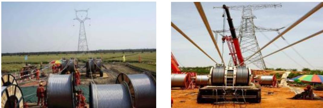
图 3.1-4 线路工程牵张场布置及张放线影像示例
