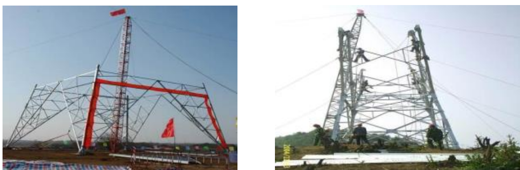
图 2-1 线路工程铁塔组立典型现场影像（示例）
