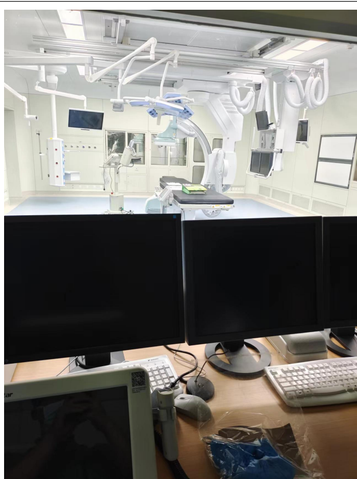
门诊住院综合楼 3FDSA 机房及控制室
