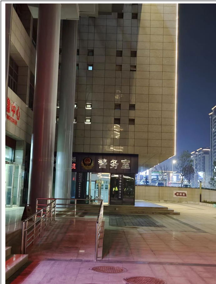
门诊住院综合楼 1F 夔州派出所驻医院警务室
