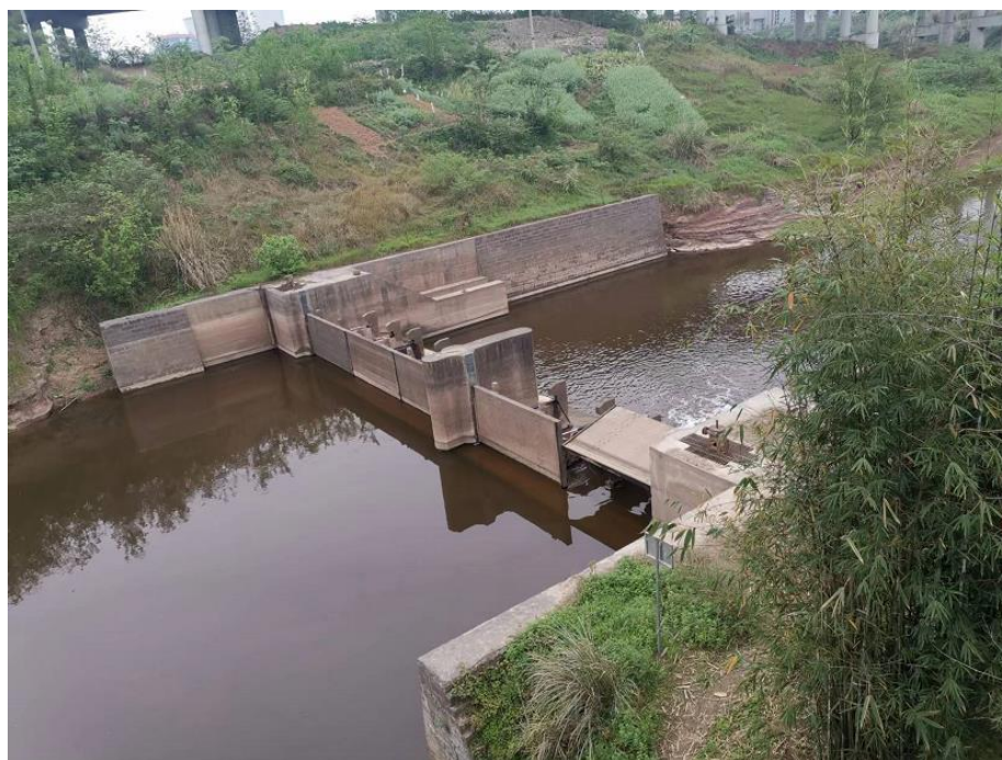
图 7.9.2-1 大陆溪河入长江前断面事故应急坝
