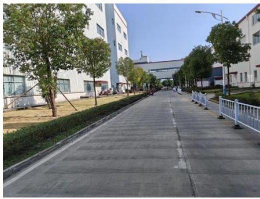
CT 室南侧厂区道路
