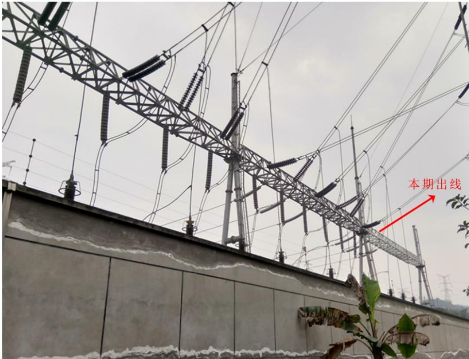
图 2-1 220kV 书房变间隔出线布置图
