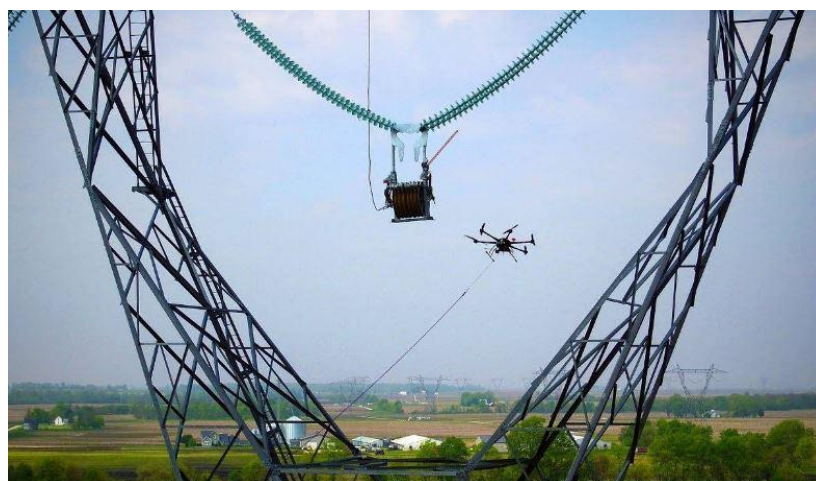
图 5-4 无人展放初级牵引绳示例
