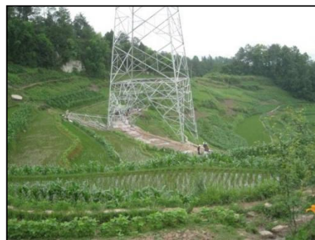
图 5-1 铁塔长短腿与不等高基础配合使用设计以及现场图
