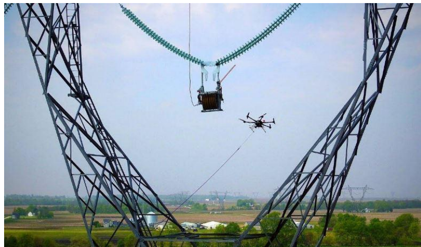
图 5-4 无人展放初级牵引绳示例
