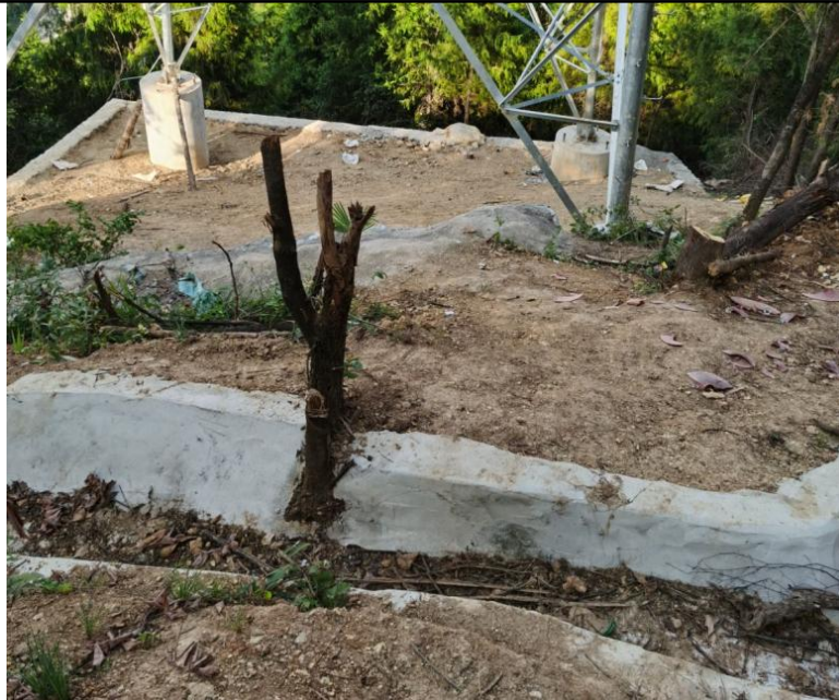
图 6.1-1 本项目 G1 塔排水沟现场照片
