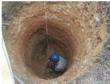
人工基础开挖
