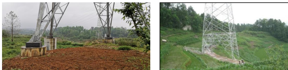
图 5-1 不等高与铁塔长短腿基础现场图
