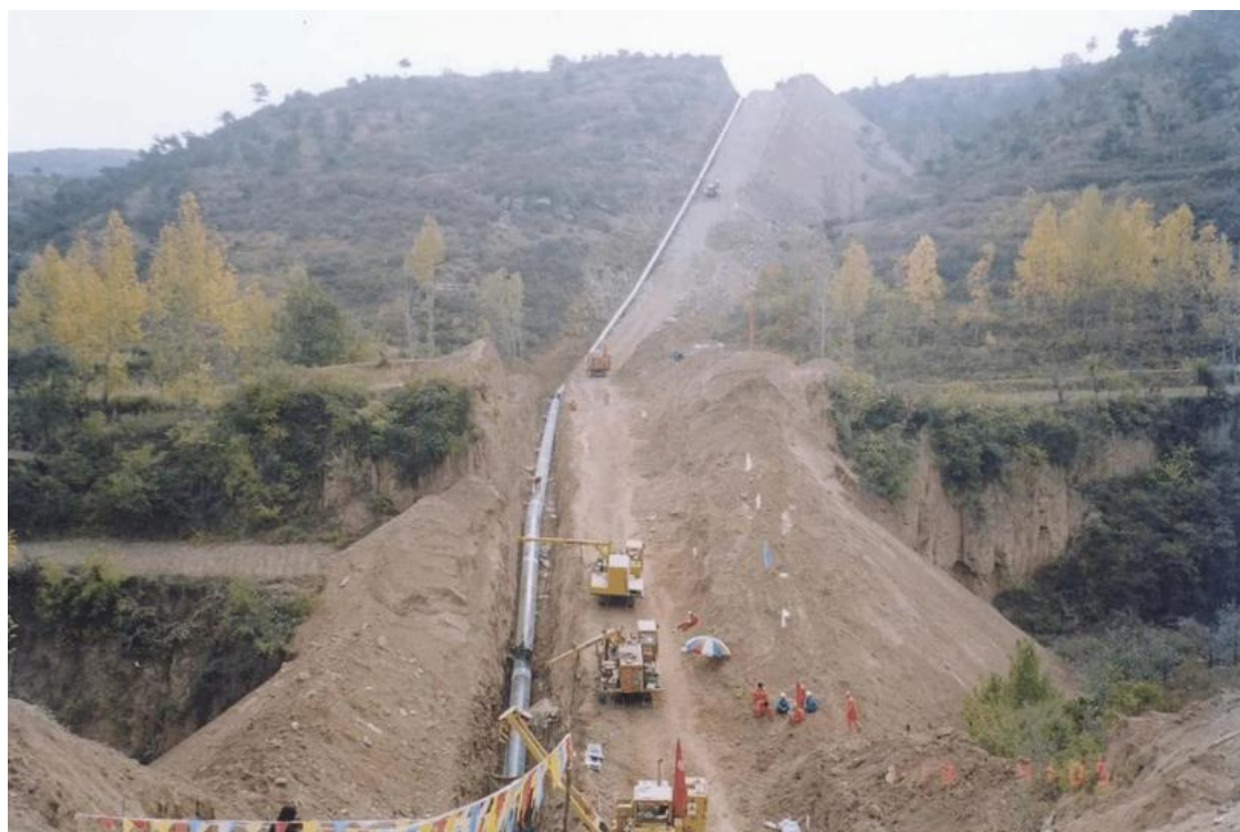
图 3.2-4 国内管沟开挖及布管实景图
