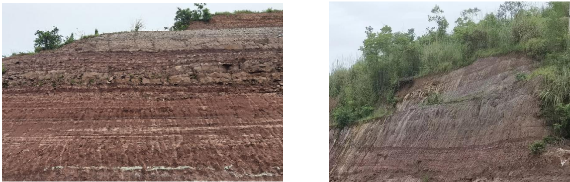
图 3.1.5-5 调查区局部裂隙发育照片
