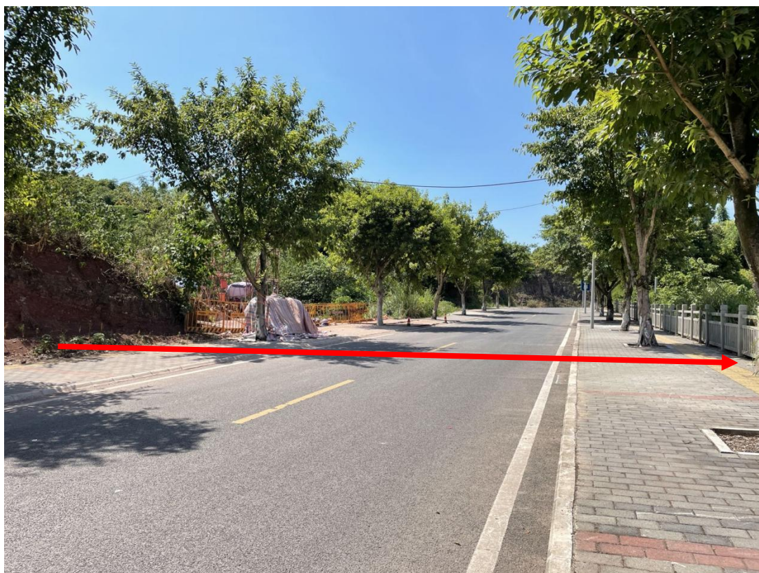
图 2.2-1 管道拟穿越现有环湖路处
