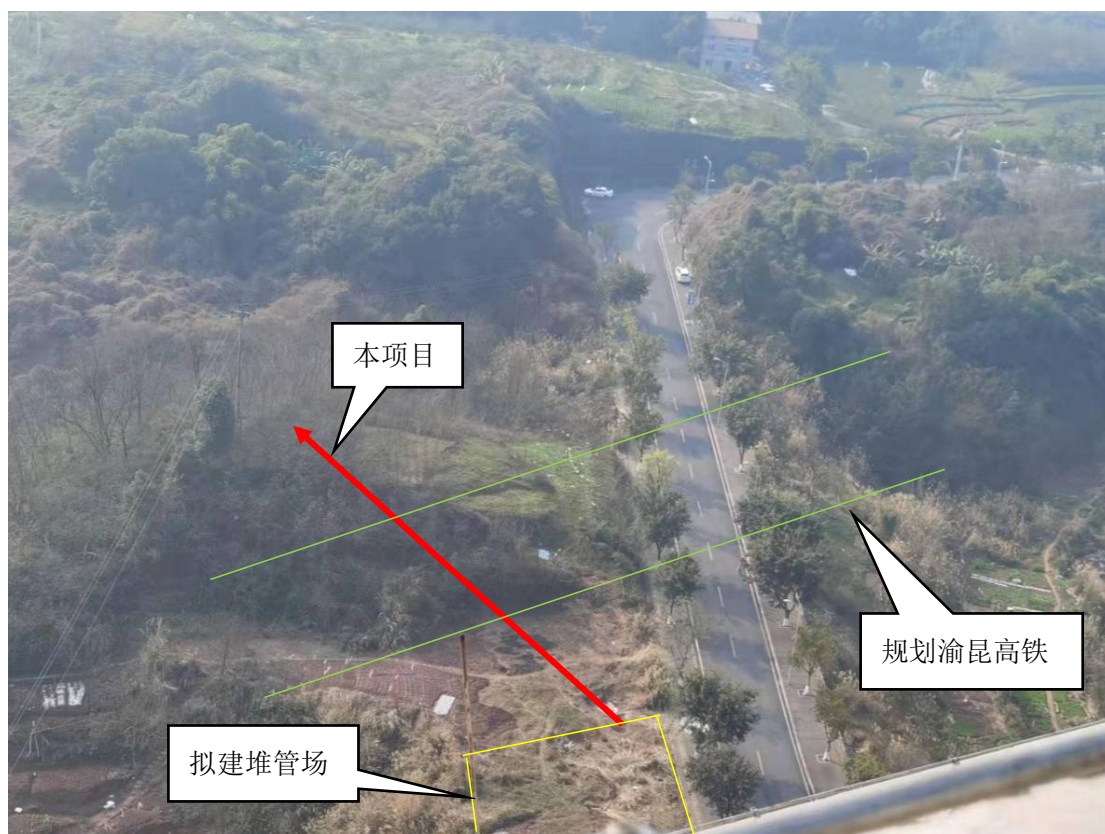
图 2.4-1 本项目拟建堆管场处现状
