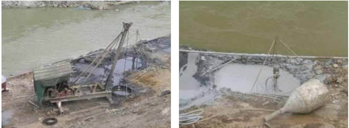
图 5.2-1 桥梁灌注桩基钻渣收集处理流程图
