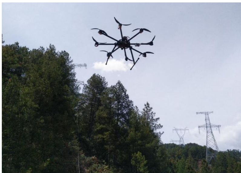
图 3-25 无人机放线施工
