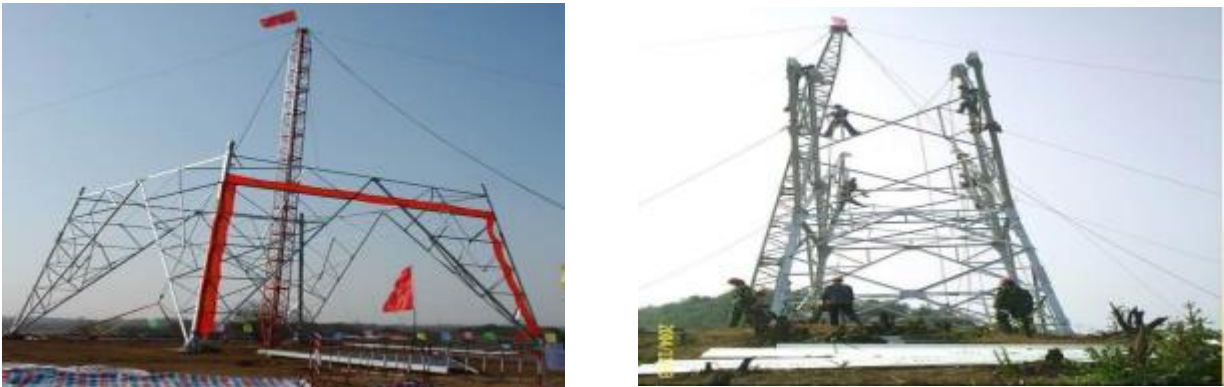
图 3-24 线路工程铁塔组立现场影像
