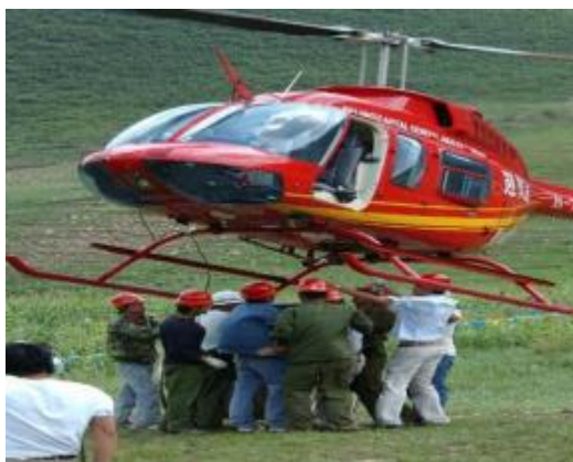
图 3-26 小型直升机展放导引绳施工工艺
