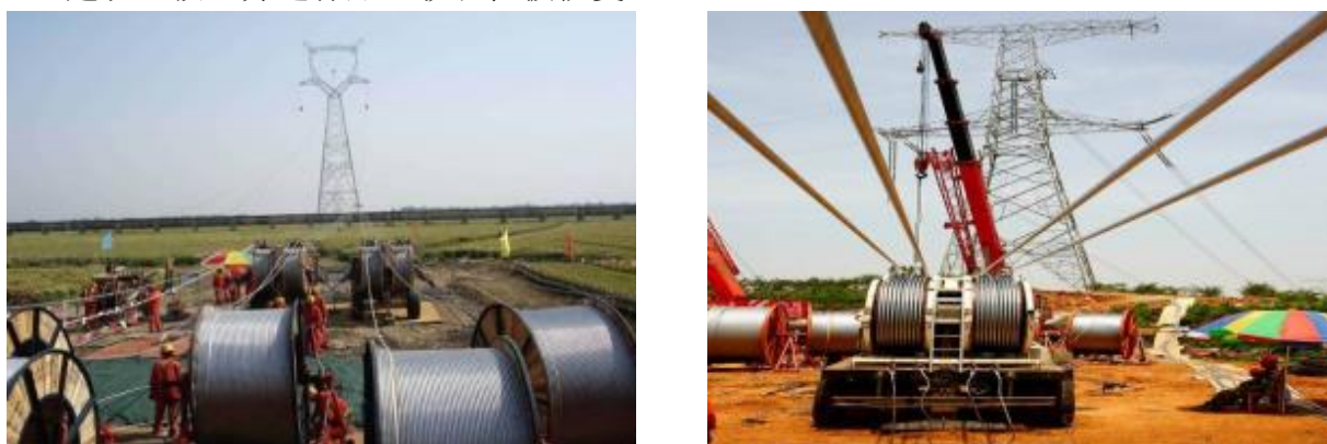
图 3-22 线路工程牵张场布置及张放线影像
