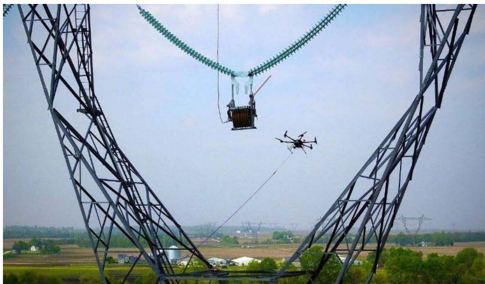
图 3-32 张力放线系统布置示意图
