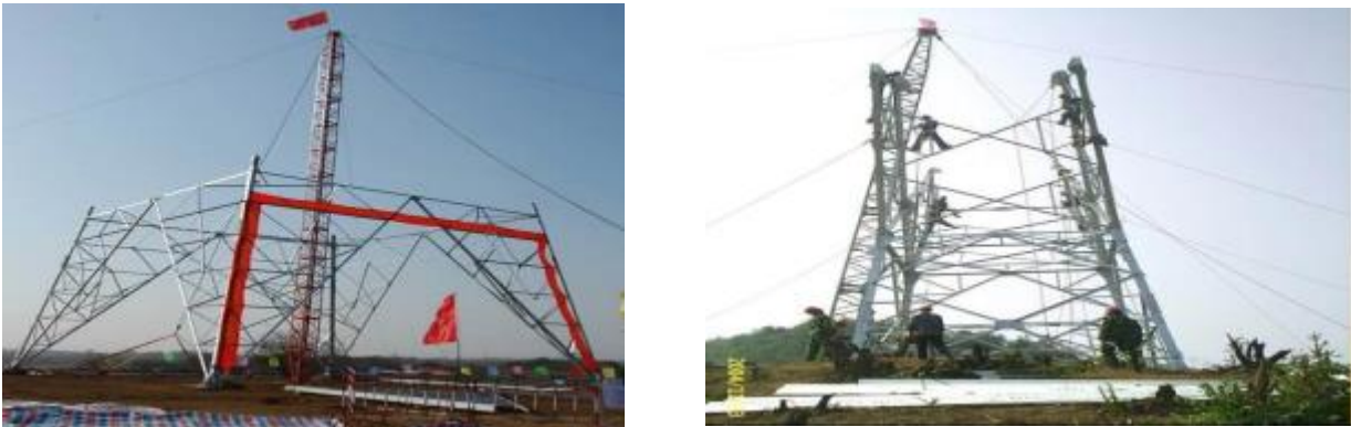
图 3-24 线路工程铁塔组立现场影像
