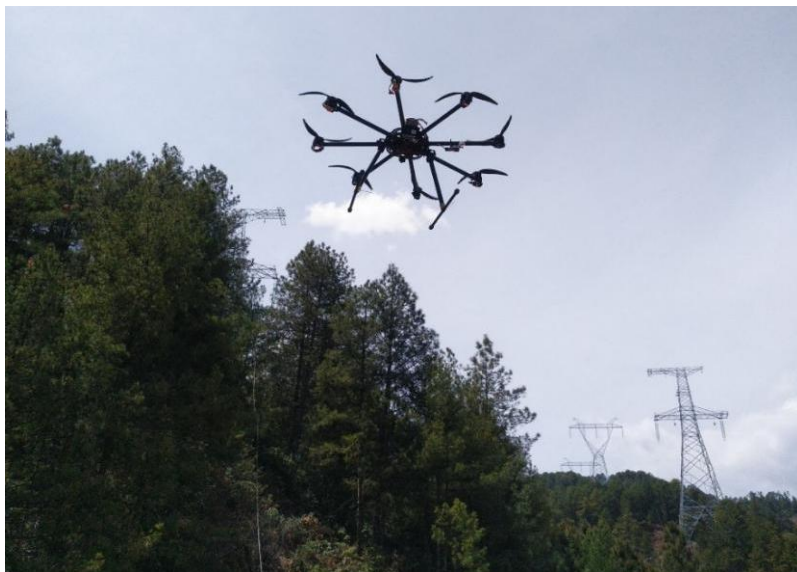
图 3-25 无人机放线施工
