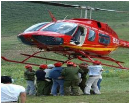
图 3-26 小型直升机展放导引绳施工工艺
