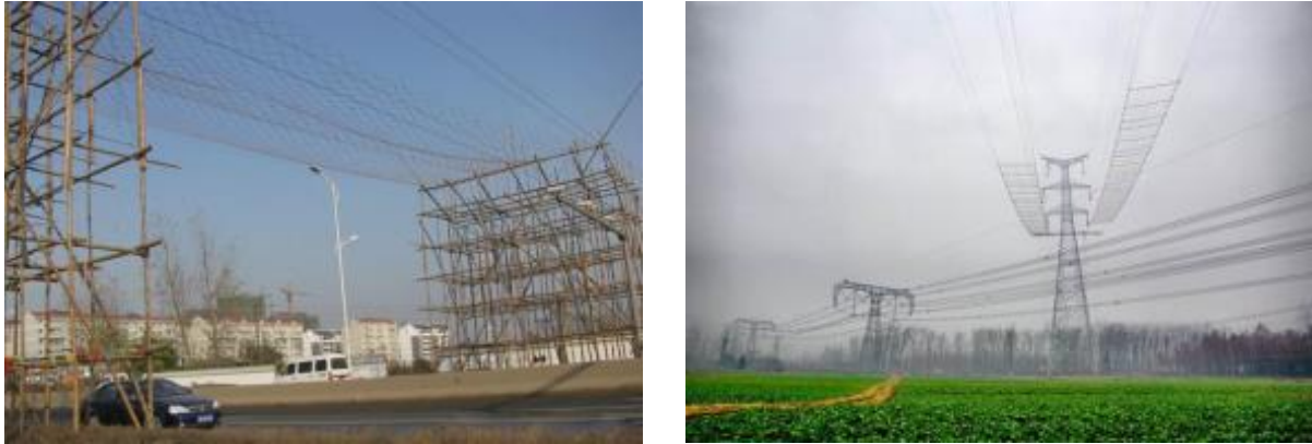
图 3-23 线路工程临时跨越施工影像
