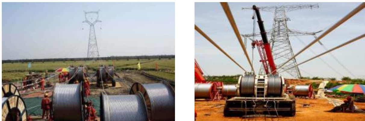
图 3-22 线路工程牵张场布置及张放线影像
