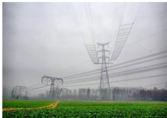
无跨越架（封网）方式示例
