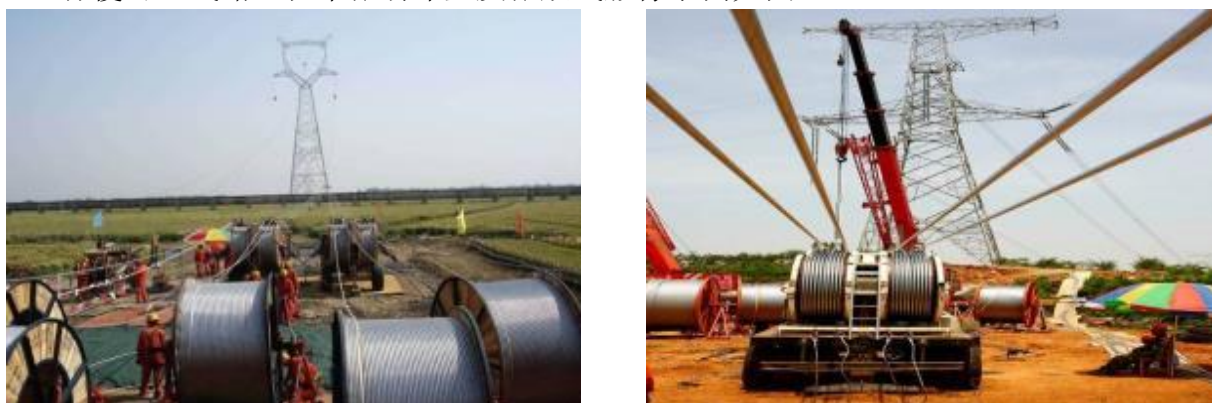
图 3.1-15 线路工程牵张场布置及张放线影像示例
