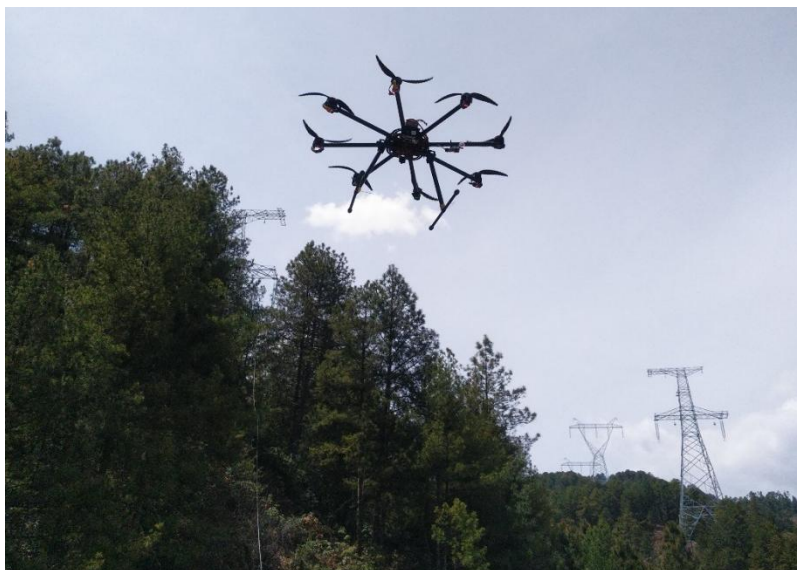
图 3.1-18 无人机放线施工示例
