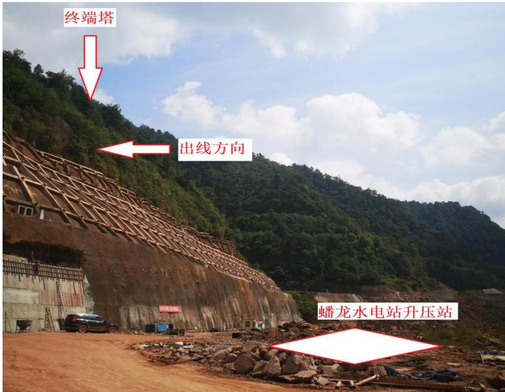
图 3.1-1 蟠龙 500kV 抽水蓄能电站升压站现状
