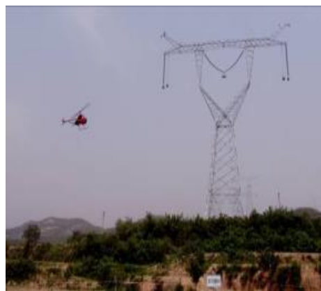
图 3.1-19 小型直升机展放导引绳施工工艺示例
