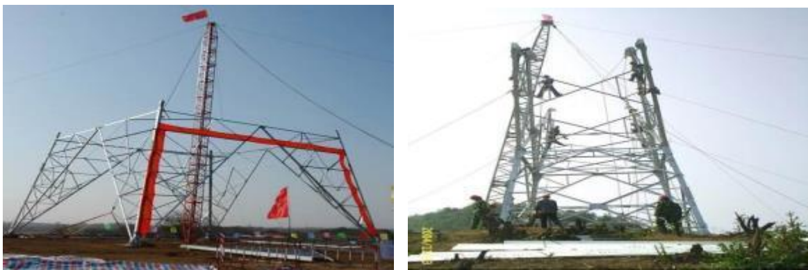
图 3.1-17 线路工程铁塔组立现场影像示例
