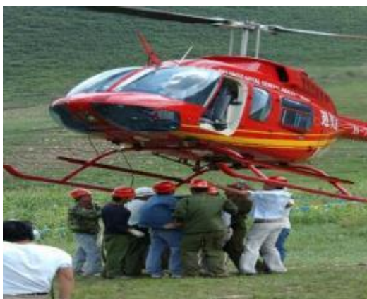
图 3.1-19 小型直升机展放导引绳施工工艺示例
