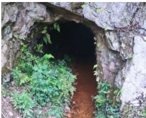
图 1-9-12 田坝煤矿四方碑排水巷道现状
