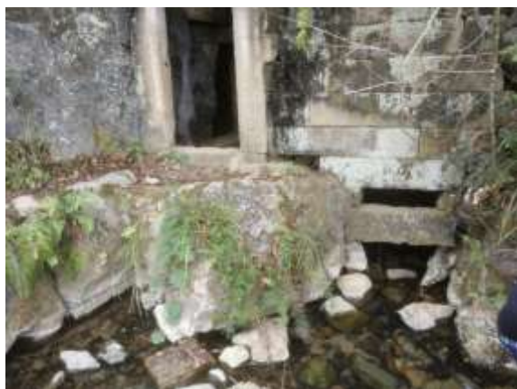
图 1-9-14 竹园村大龙坎取水点现状
