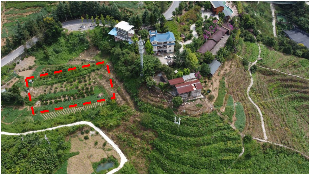
图2.2-8 白水首站现场照片（虚线为占地范围示意线）
