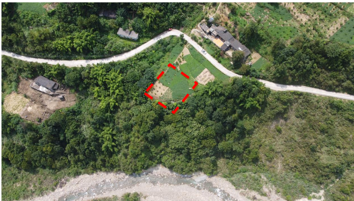
图2.2-9 九拐村截断分输阀室现场照片（虚线为占地范围示意线）
