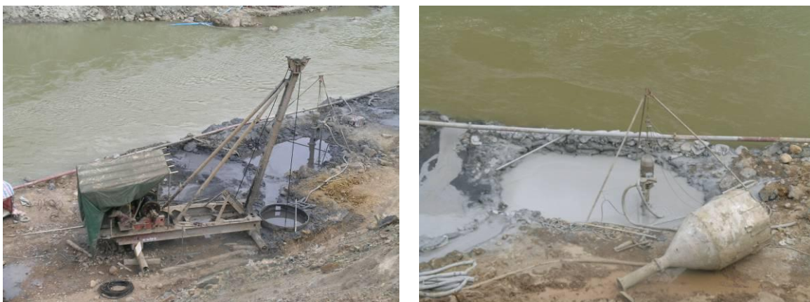
图 5.2—2 桥梁灌注桩基钻渣泥浆收集处理及利用
