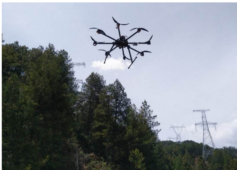
图 3-6 无人机放线施工
