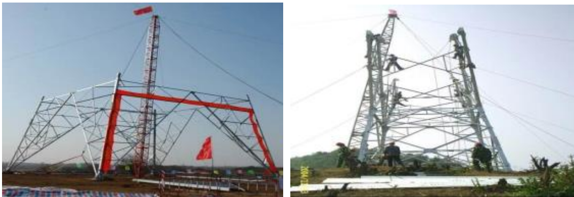
图 3-5 线路工程铁塔组立现场影像
