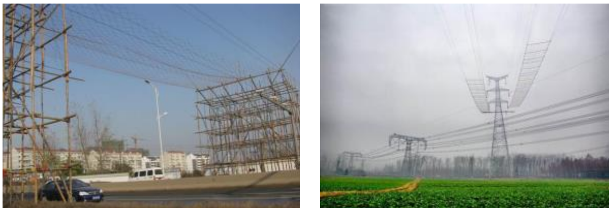
图 3-4 线路工程临时跨越施工影像
