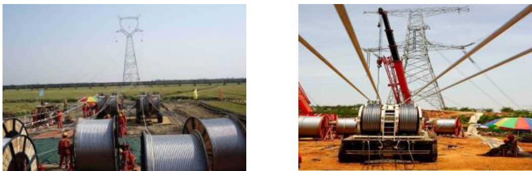
图 3-3 线路工程牵张场布置及张放线影像
