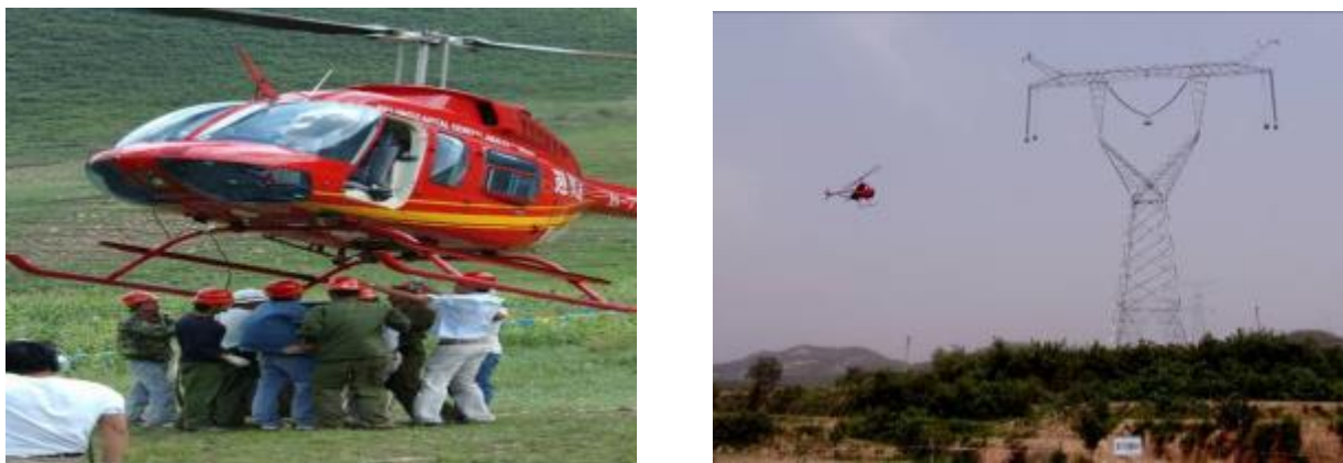
图 3-7 小型直升机展放导引绳施工工艺
