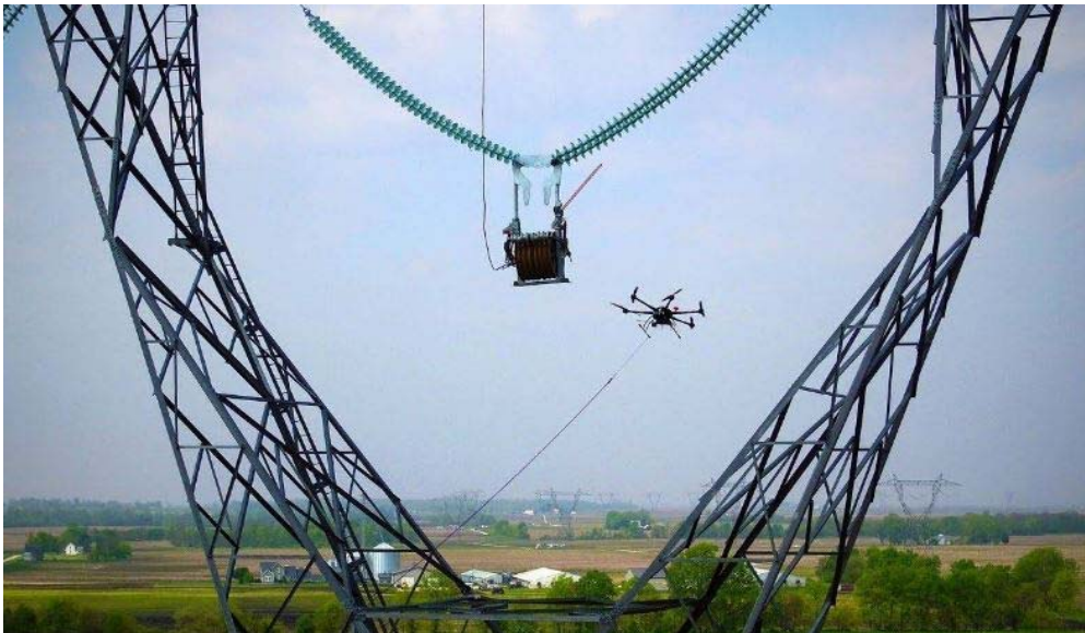
图 3-14 张力放线系统布置示意图
