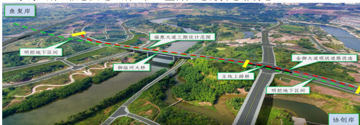
图 2.1.7-1 拟建御临河大桥周边环境
