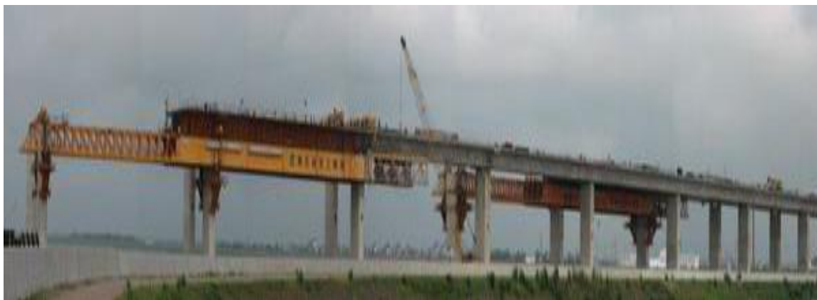
图 2.1.12-2 移动模架现场施工
