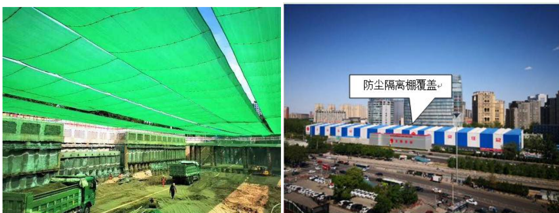
图 6.7-1 防尘隔离棚覆盖实例图
