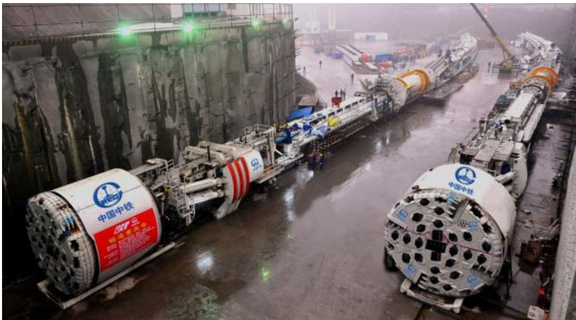
图 2.1-25 TBM 法施工设备
